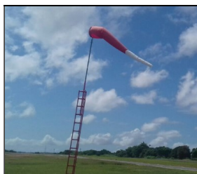
Figura 3 - Biruta não-iluminada existente no aeródromo de Flores
