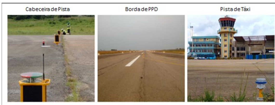
Figura 33 - Modelo de balizamento fotovoltaico
