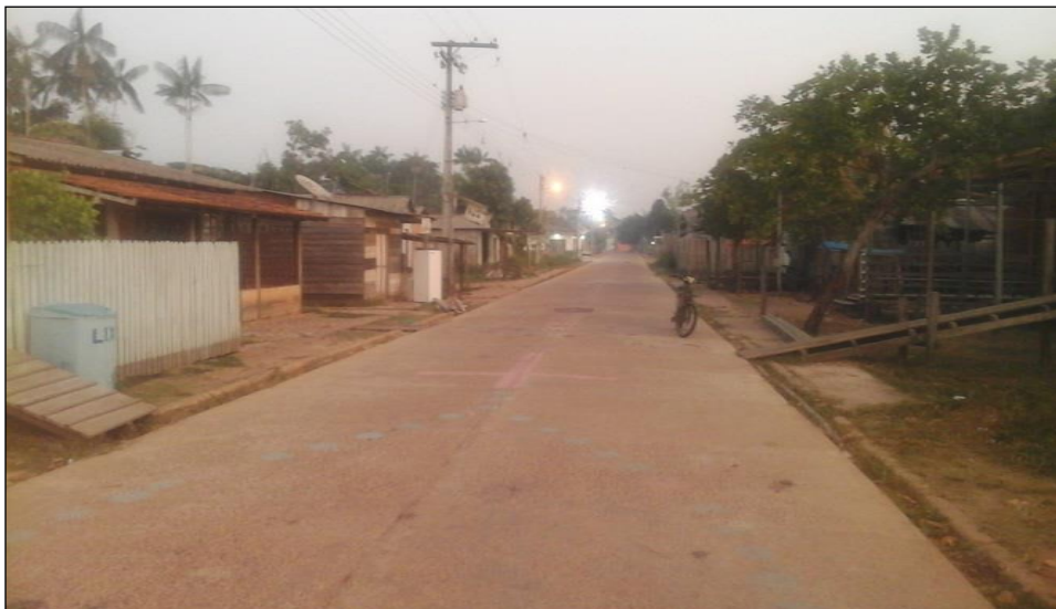
Figura 03: Rua Maria Belém principal via de acesso do Bairro no período que não está alagada. Foto: Gerson Mesquita, 2015.
