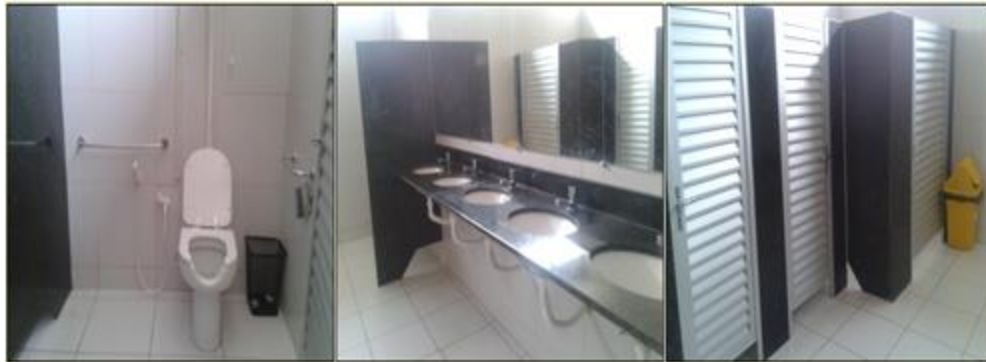
Figura 20: Banheiros do Porto de Parintins Fonte: Pesquisa de Campo (2015)
