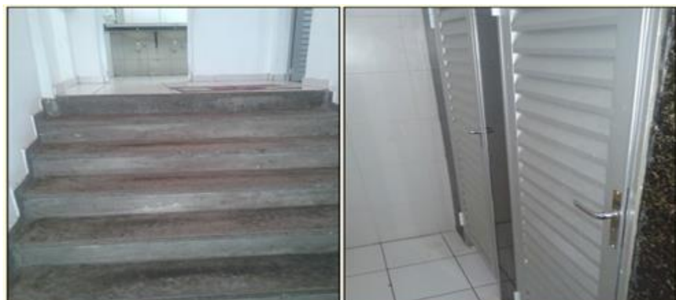
Figura 19: Banheiros do Porto de Parintins Fonte: Pesquisa de Campo (2015)
