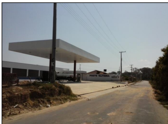
Figura 2: Posto de gasolina em processo de construção. Fonte: Viana, 2015.
