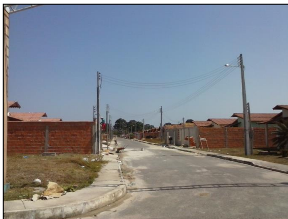
Figura 3: Algumas casas que já possuem o muro. Fonte: Viana, 2015.
