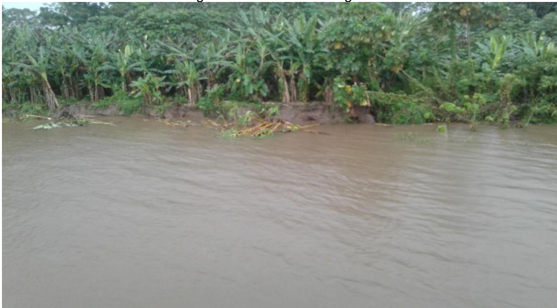
Figura 35. Queda da margem
