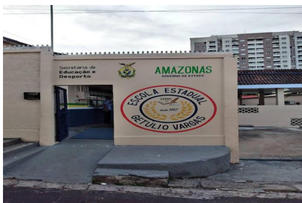
Figura 1. Escola em que houve a intervenção.
