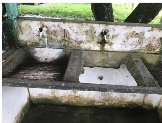
Fotografia 03: Foto da pia de cozinha 12 :
