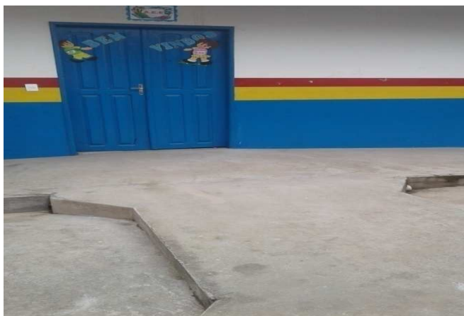
Foto 2 – Entrada da sala do AEE
