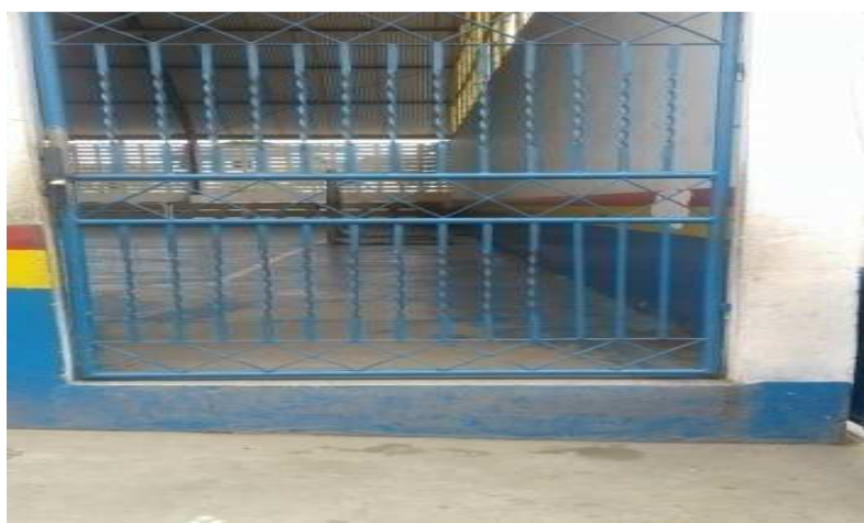
Foto 5: Entrada da quadra (não adaptada)
