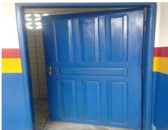
Foto 9: Banheiro com a porta adaptada
