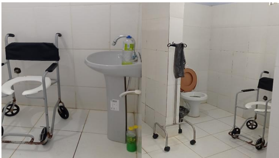
Figura 3 – Banheiro da Ala de Internação Pediátrica, 2023.
