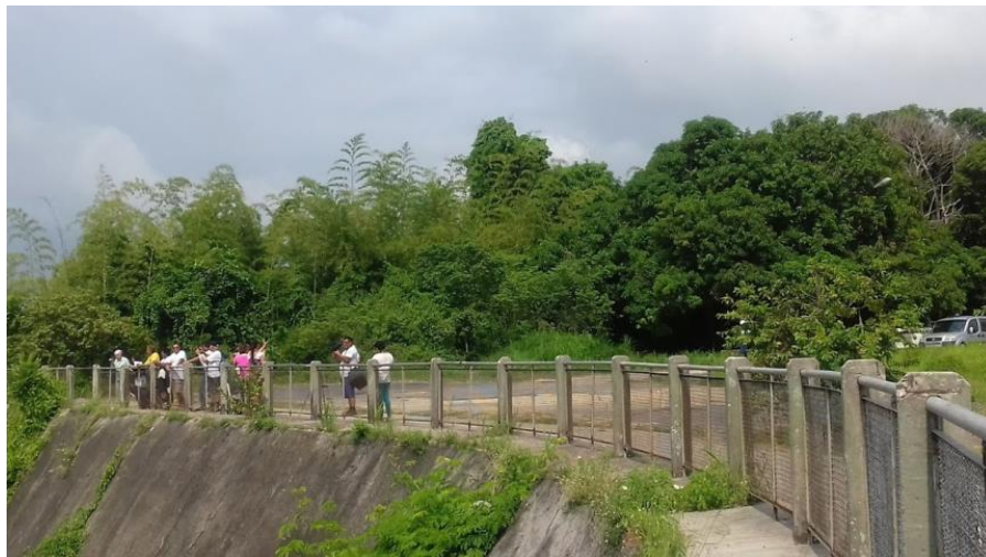
Figura 16 - Infraestrutura do Mirante das Lajes
