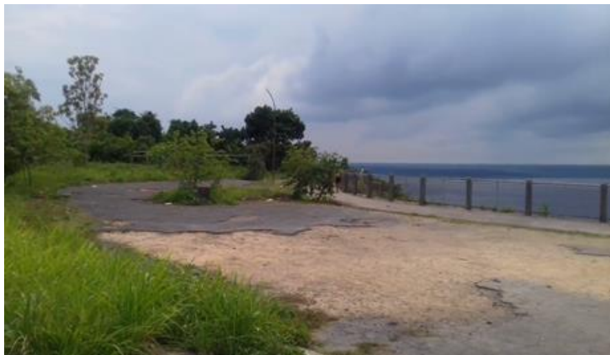
Figura 17 - Piso da estrutura do Mirante das Lajes
