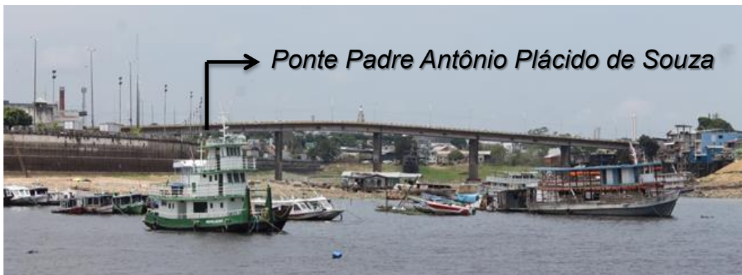
Figura 26 - PONTE PADRE ANTÔNIO PLÁCIDO DE SOUZA SOBRE O IGARAPÉ DO EDUCANDOS
