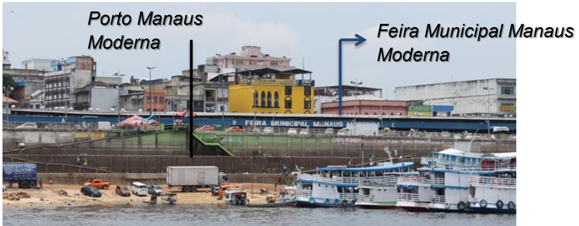
Figura 23 - FEIRA MUNICIPAL MANAUS MODERNA E PORTO DA MANAUS MODERNA
