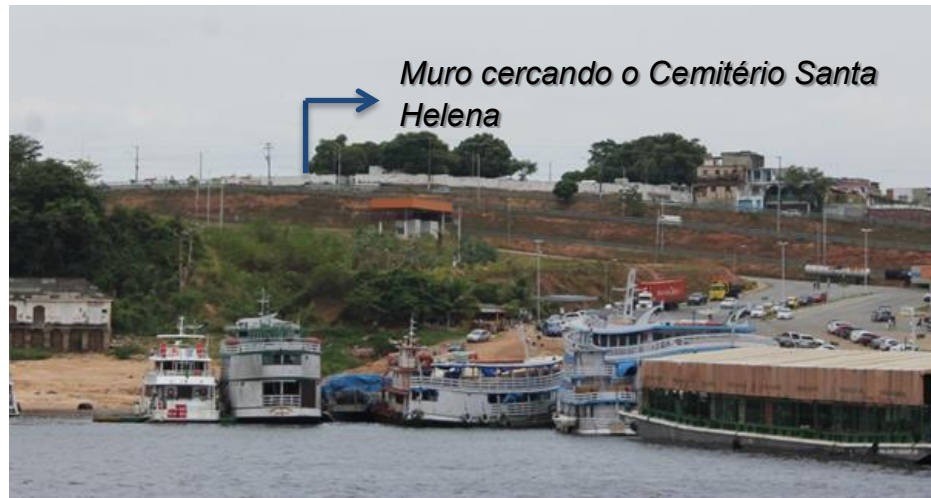
Figura 9 - MURO BRANCO AO FUNDO, QUE CERCA O CEMITÉRIO SANTA HELENA
