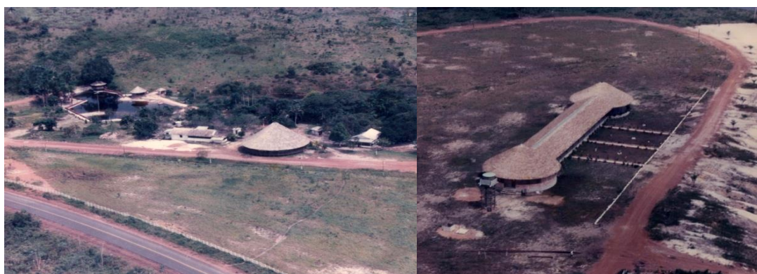
Figura 13 - Monte Sião com cobertura inspirada nas ocas indígenas.
