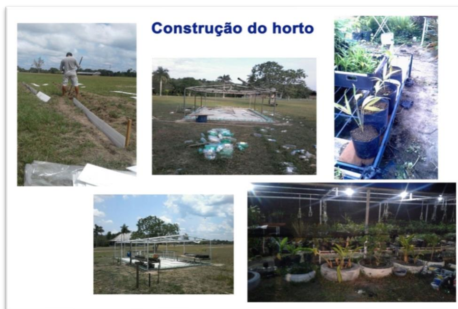
Figura 17- Estrutura e construção do Horto
