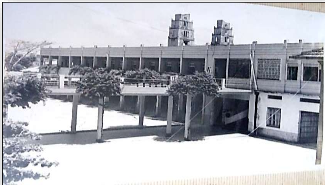
Figura 10 – Fachada lateral do Centro Educacional Santa Teresinha
