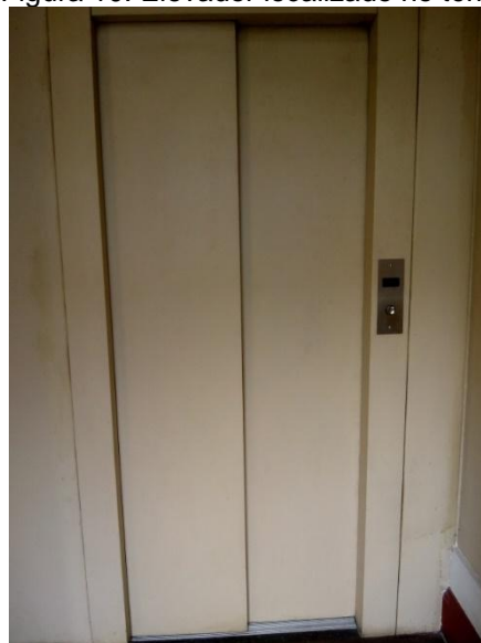
Figura 10: Elevador localizado no térreo
