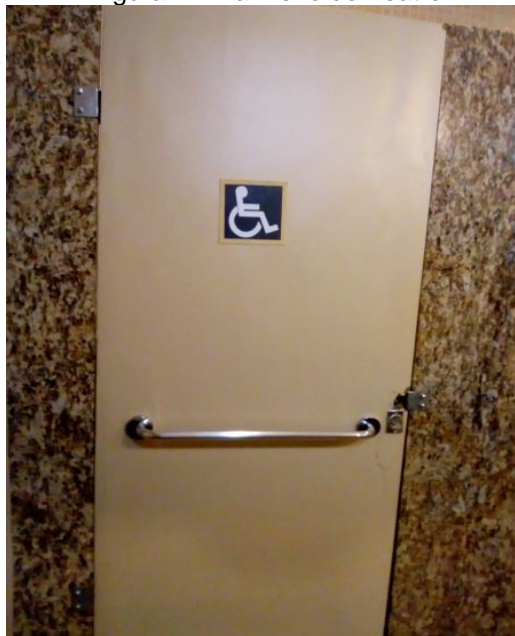
Figura 12: Banheiro do Teatro
