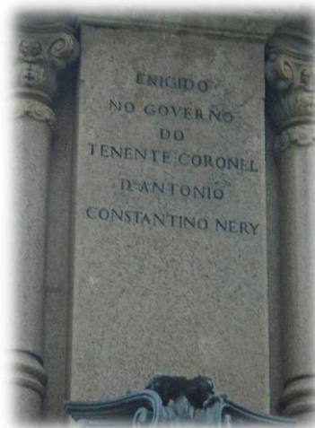
Figura 49: Identificação da edificação da obra.
