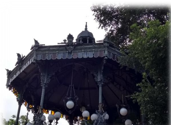
Figura 27: Detalhes da cúpula do Coreto de Ferro.
