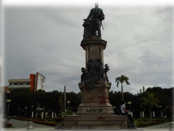
Figura 51: Danificações no Monumento à Tenreiro Aranha.
