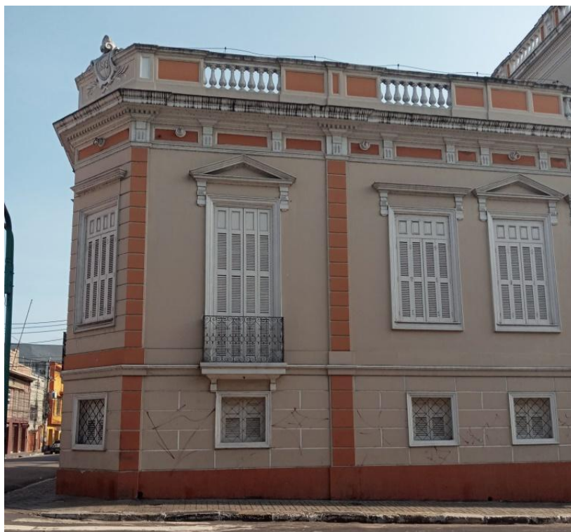
Figura 44 - Vista lateral na Rua dos Andradas.
