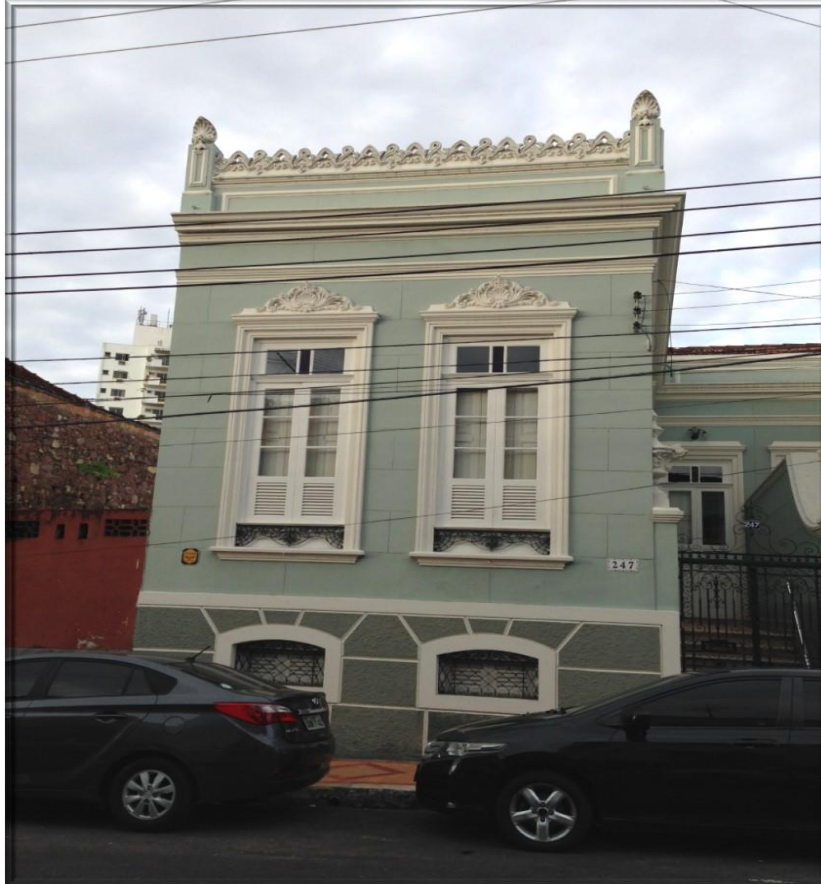
Figura 14 – Fachada com a presença de gateiras com gradil
