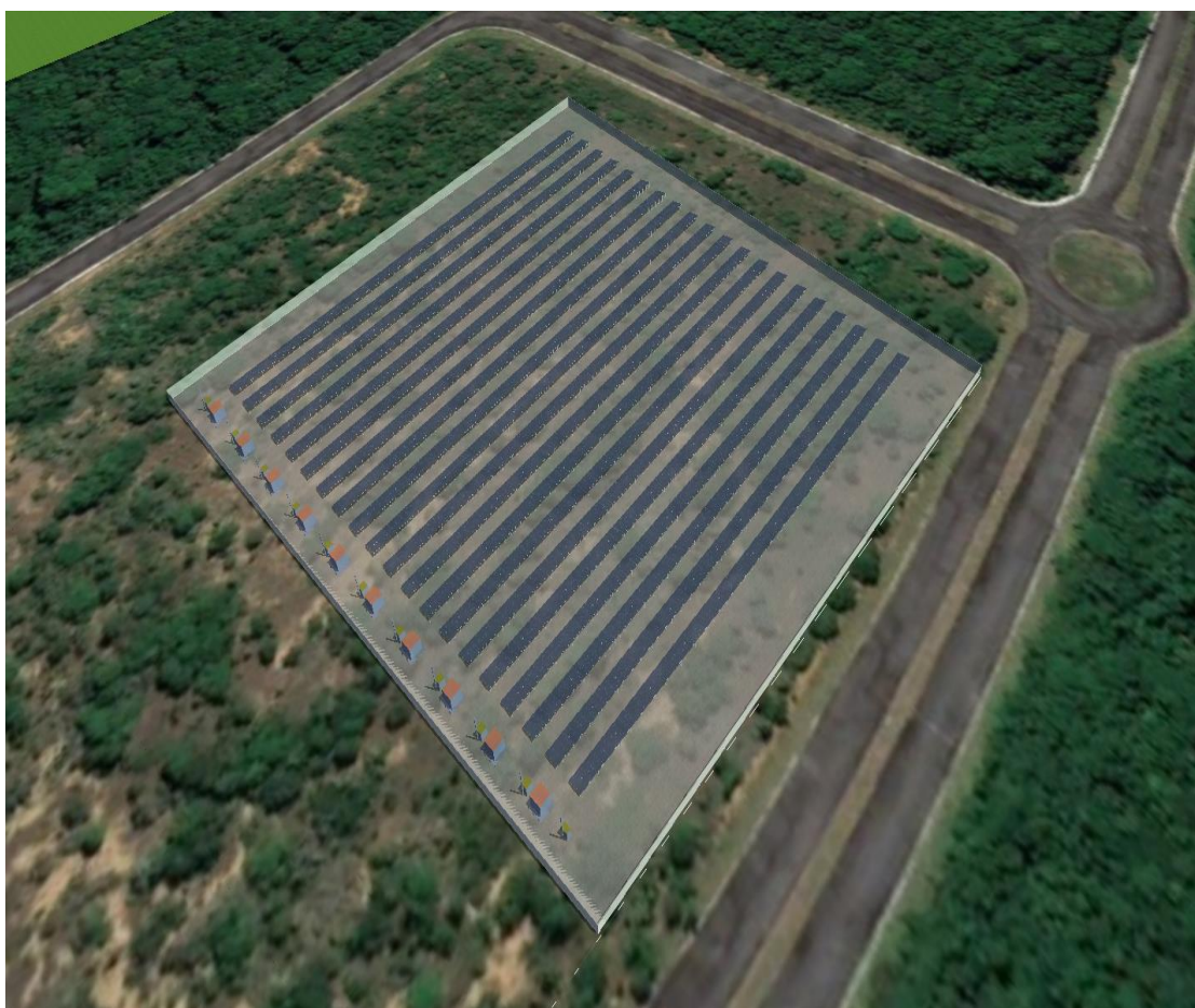
Figura 18 - Vista Geral da Usina
