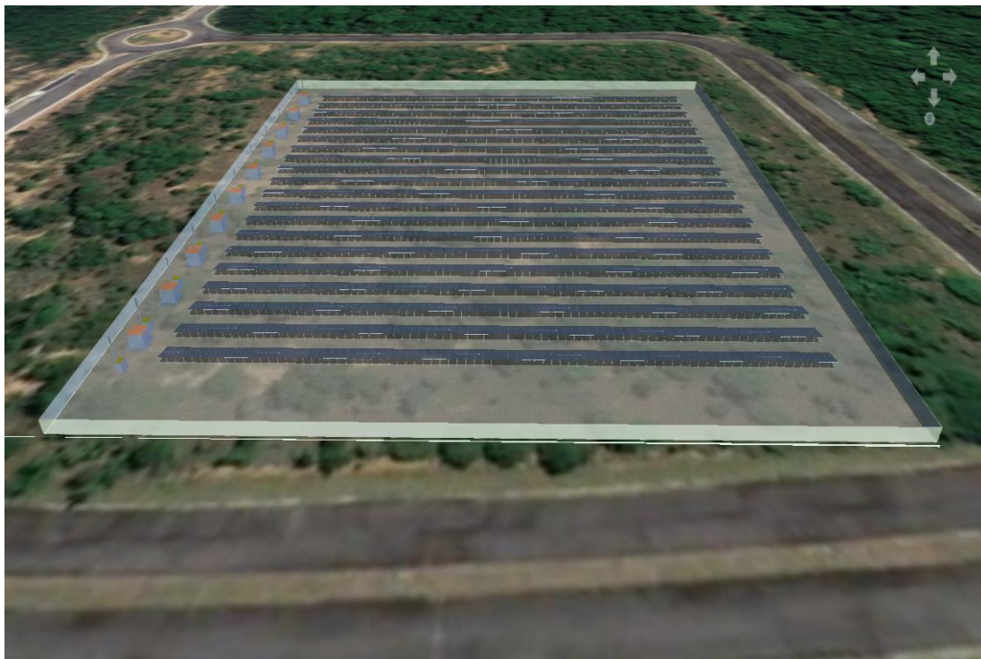
Figura 19 - Vista Geral da Usina
