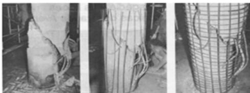
Figura 4 – Sequência de fotos de ~~encamionamento~~ de pilar – Incêndio Edifício Grande Avenida, São Paulo, 1981. Fonte: <http://zonaderisco.blogspot.com.br/2014/04/lembranca-incendio-do-edificio-grande.html>. Acesso em 25/11/2015.
