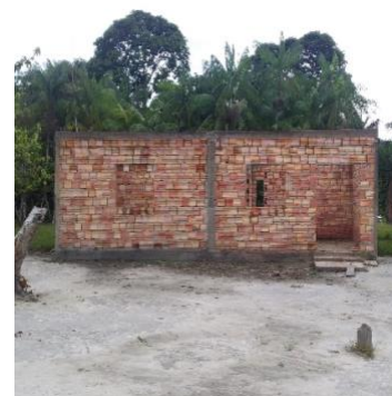
Imagem 05. Casas em construção na Comunidade Betel.
