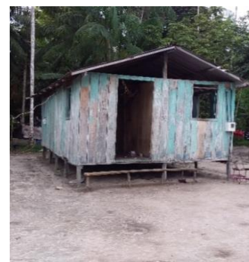
Imagem 03. Casa de madeira simples na Comunidade Barreira de Baixo.
