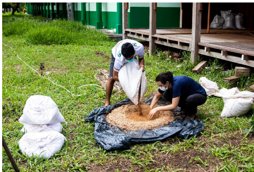
Figura 9. Mistura da serragem ao barro.
