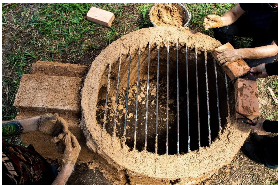
Figura 12. Câmara de combustão e grade.
