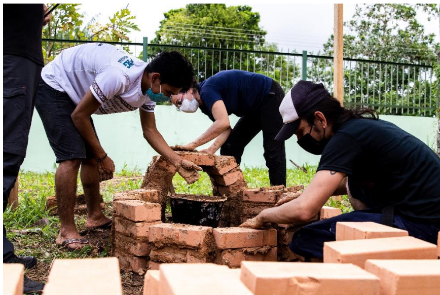
Figura 11. Construção da entrada da câmara de combustão.
