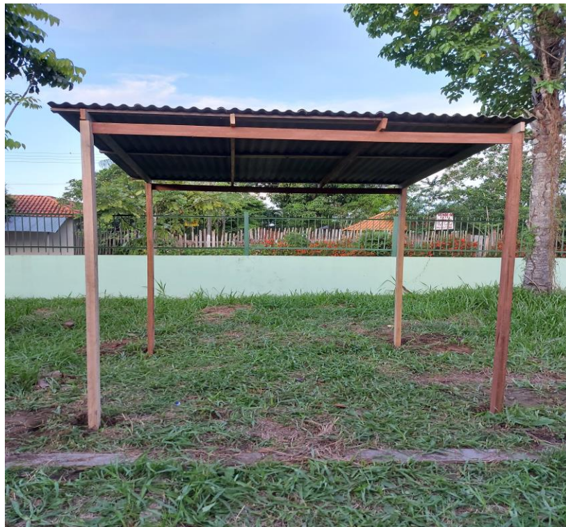
Figura 6. Cobertura para proteção do forno.
