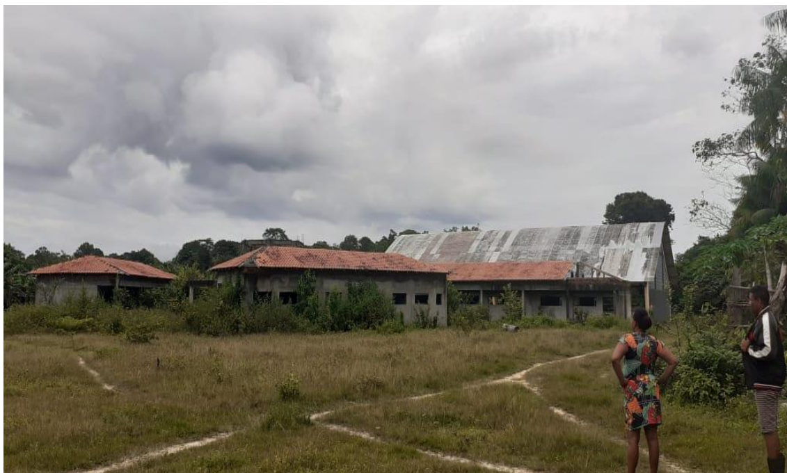
Figura 5 - Obra inacabada da nova sede da Escola Municipal Bom Jesus
