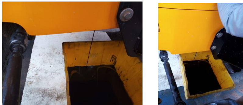
Figura 33 e figura 34: Remoção de Óleo de motor
