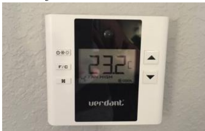
Figura 26 - Controle de ar do data center.
