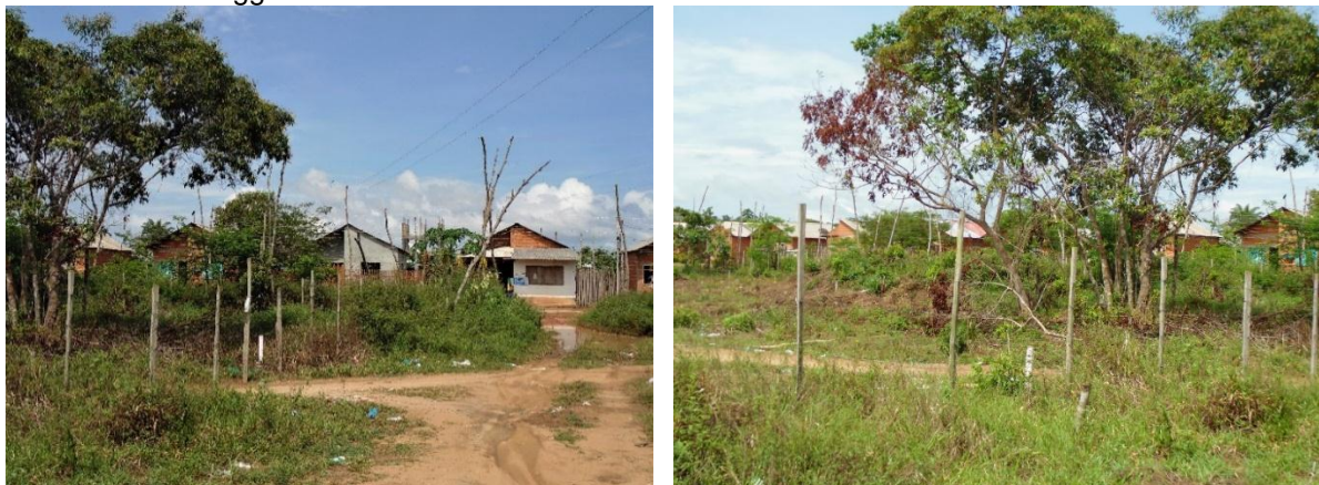
Figuras 21 e 22. Residências da área C do bairro Jacareacanga, localizadas na extremidade com o bairro Pascoal Alággio na cidade de Parintins- Am.
