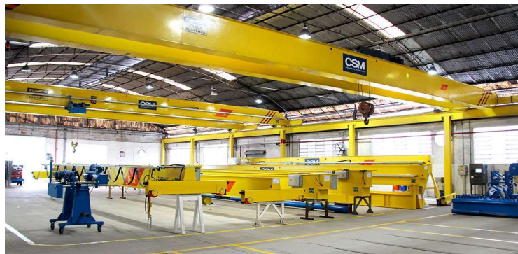
Figura 4 - Viga Principal da ponte rolante
