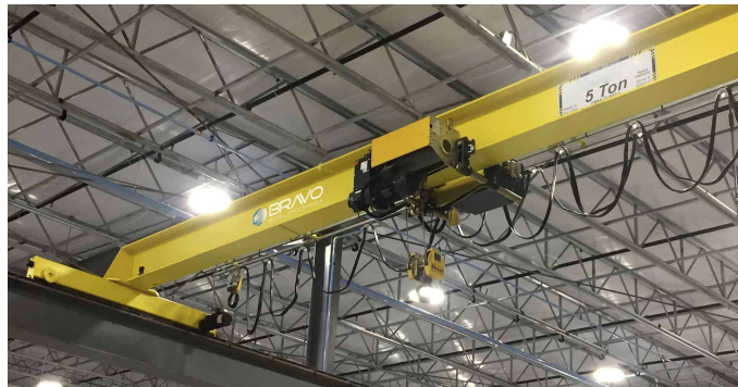
Figura 8 - Univiga de uma ponte rolante
