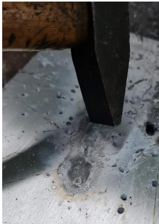
Figura 40 - Remoção da escória de solda
