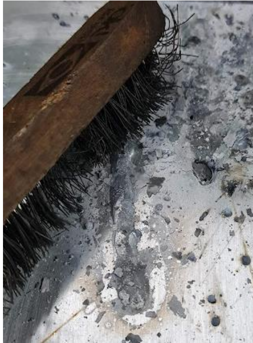
Figura 41 - Limpeza com escova de aço
