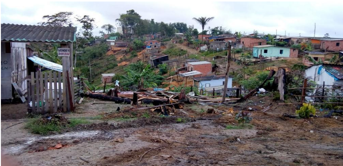
Figura 6 - Remoção de Famílias na Ocupação Irregular Monte Horebe
