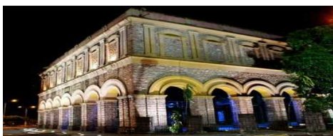
Figura 9: Reservatório do Mocó
