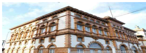
Figura 4: Prédio da Alfândega
