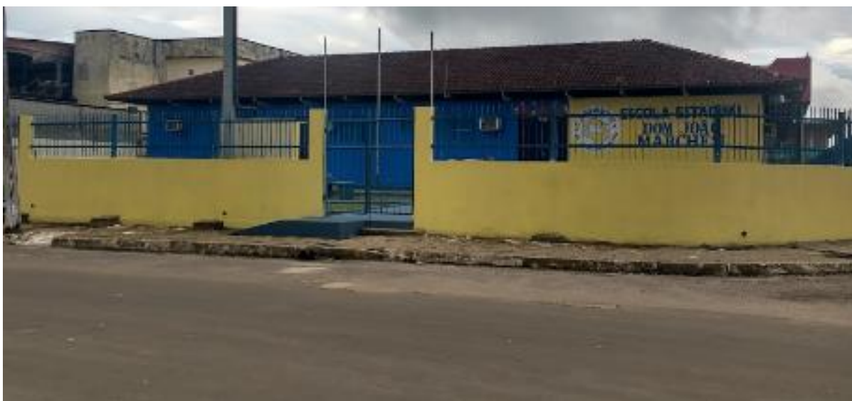
Figura 1. Fachada da Escola Estadual Dom João Marchesi
