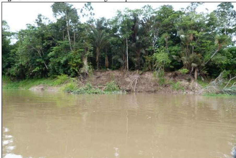
Figura 4: Processos erosivos na margem esquerda do Paraná do Ramos
