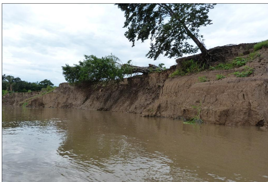
Figura 5: Processos erosivos na margem esquerda do Paraná do Ramos
