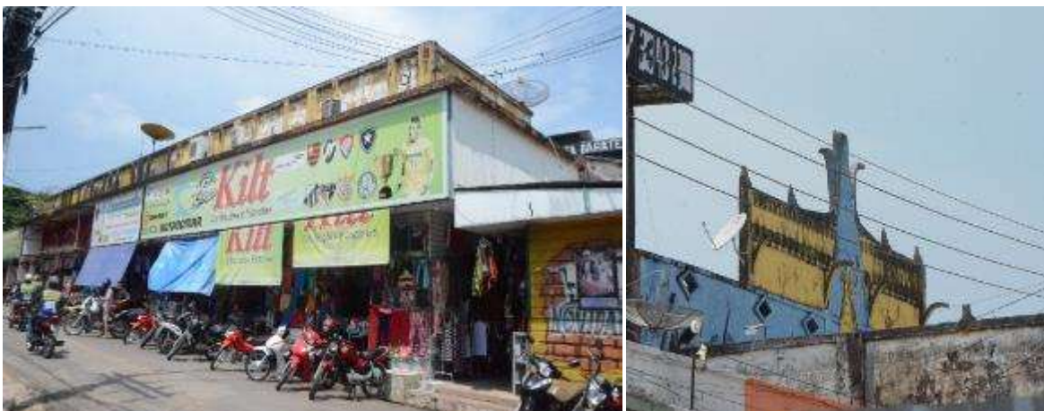
Figura 31: Estrutura do Mercado Municipal de Tefé atualmente.
