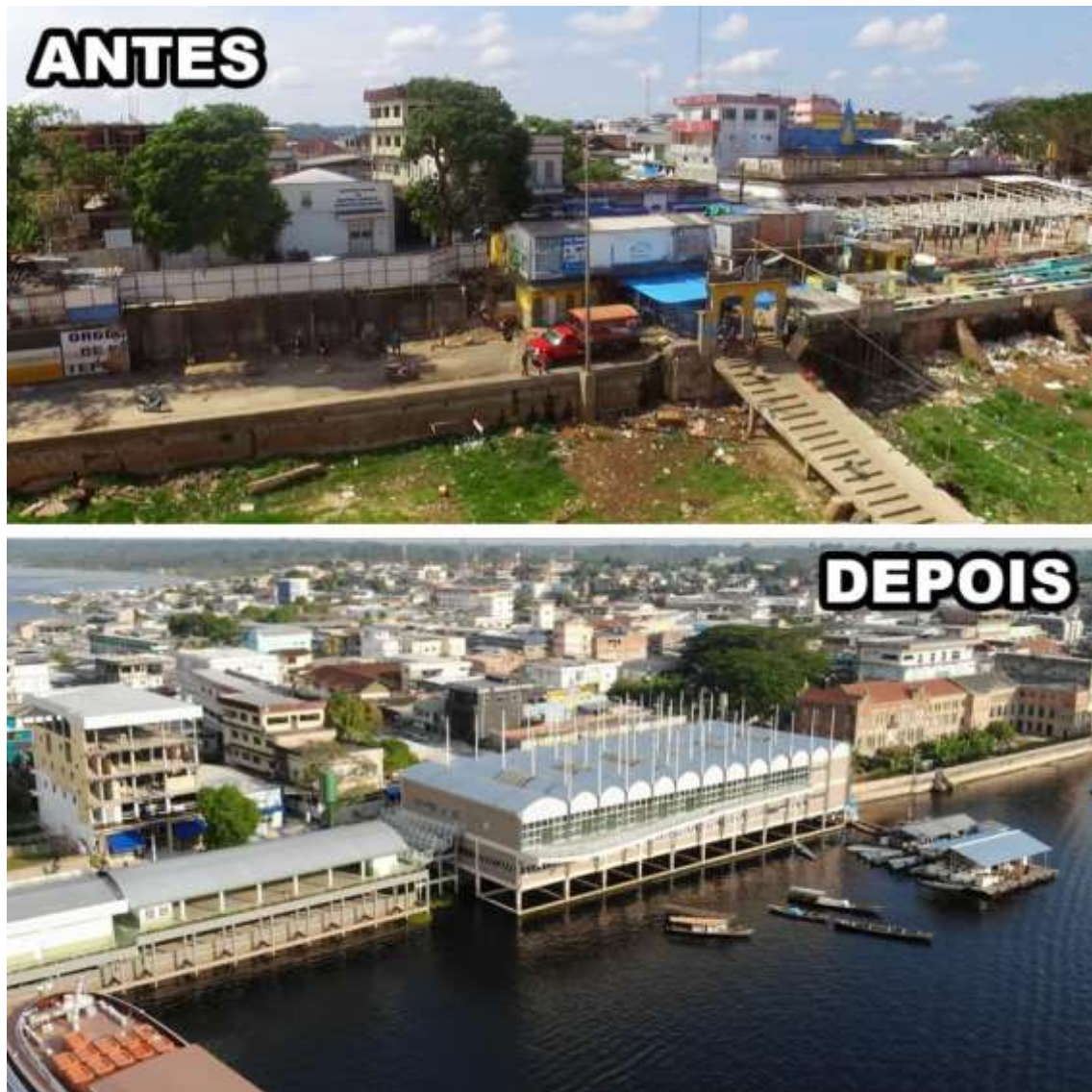
Figura 48: Antes e depois do projeto de revitalização da área frontal da cidade em 2019.
