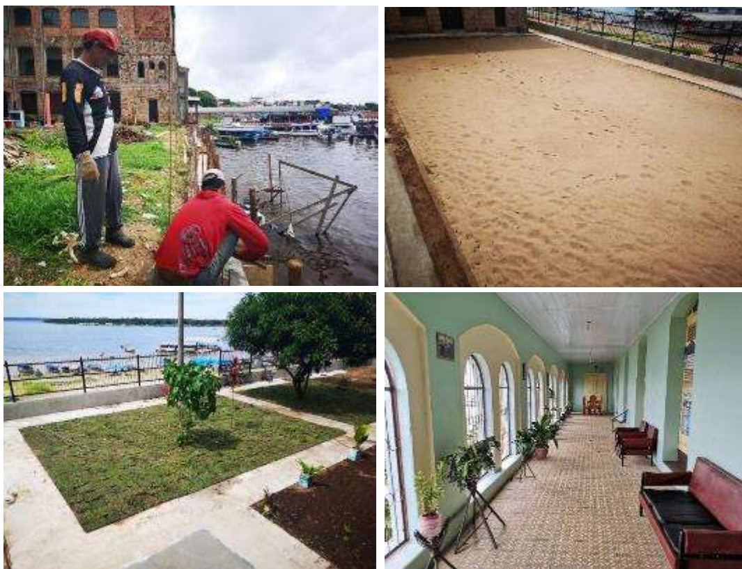
Figura 25: Reformas no Seminário São José
