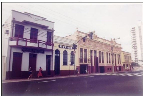
Figura 20. Conjunto Arquitetônico, após a restauração, localizado entre a ponte Romana I e o Palácio Rio Negro, em 1998
