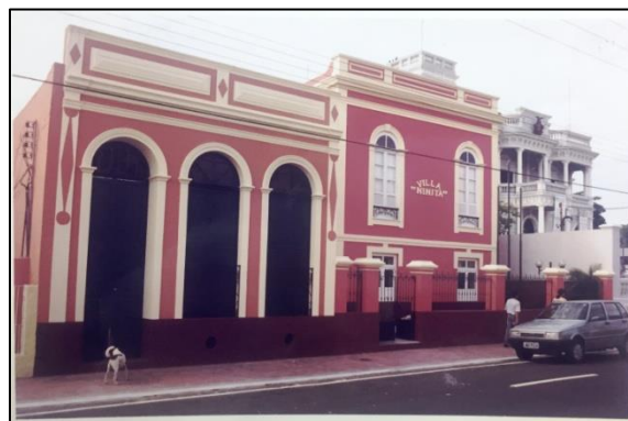
Figura 21. Edificações após a restauração, localizadas entre o Palácio Rio Negro e a ponte Romana II, em 1998
