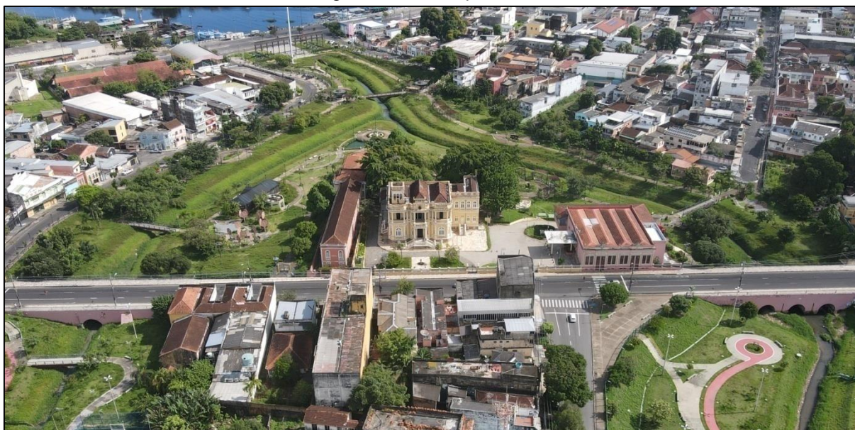
Figura 33. Imagem aérea do entorno do Centro Cultural Palácio Rio Negro e Parque Senador Jefferson Péres. Registro realizado por meio de drone em 2021
