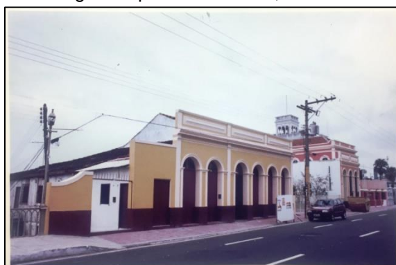
Figura 23. Último imóvel do projeto, após a restauração, localizado entre o Palácio Rio Negro e a ponte Romana II, em 1998
