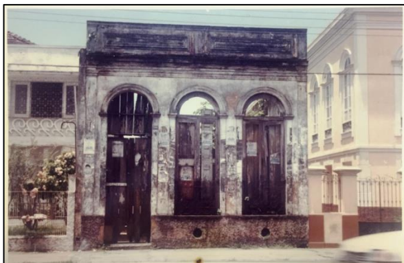
Figura 25. Fachada do imóvel ao lado da Vila Ninita, no sentido da ponte Romana II, em 1997
