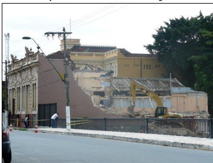
Figura 28. Foto tirada em janeiro de 2010 dos casarões geminados sendo demolidos
