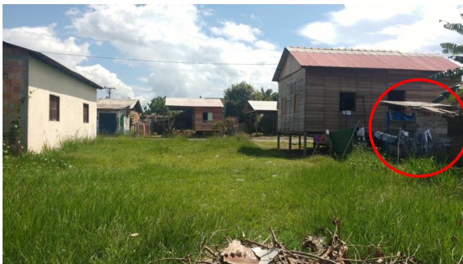
Imagem 03. Casa com banheiro fora.
