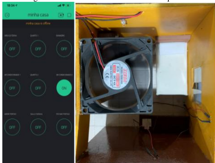
Figura 35: Acionamento ar condicionado quarto 2
