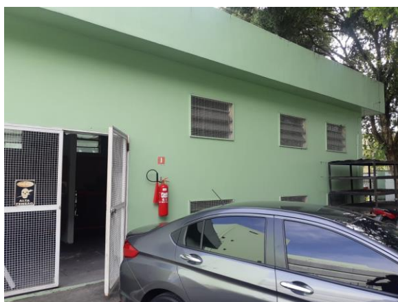
Figura 9 - Subestação Abrigada da Escola Superior
