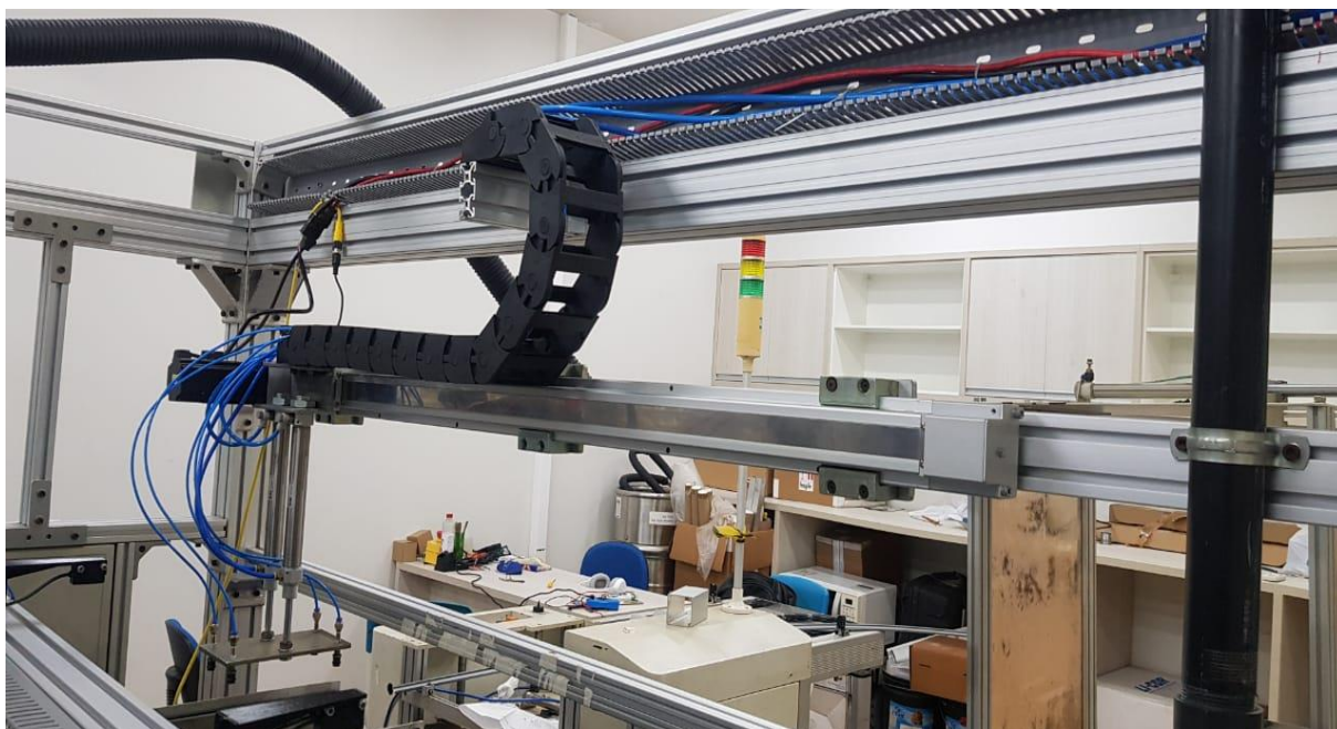
Figura 19 - Exemplo da fixação dos tubos de poliuretano.
