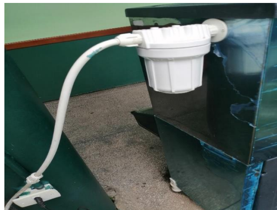
Figura 20- Filtro do bebedouro
