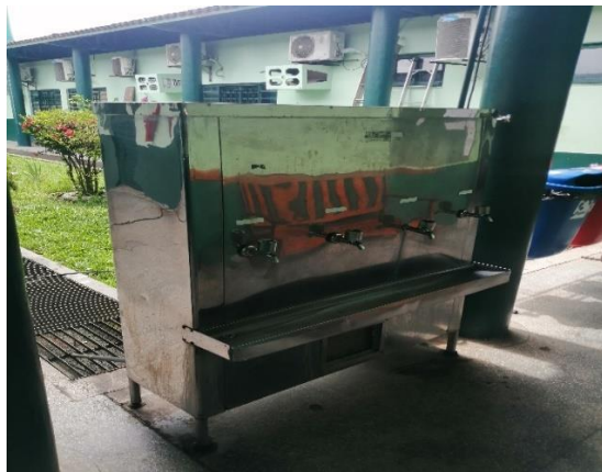
Figura 19- Armazenamento da água
