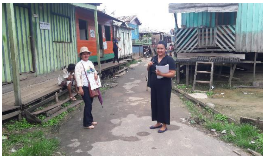
Figura 14: Rua José Luciano Alves, casas de madeira com piso suspenso. Fonte: Trab. de Campo: (Foto: Naraiza C. Lira, 2020).
