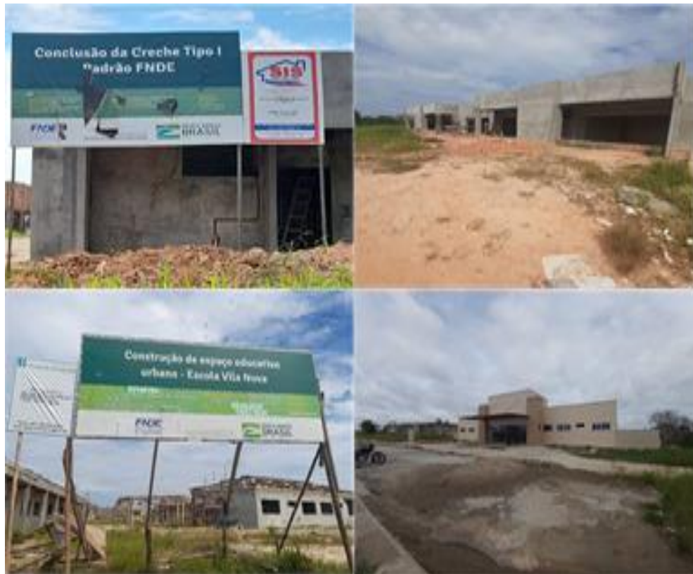
Figura 16: Escola, creche e posto de Saúde - Obras em andamento Fonte: Trabalho de Campo 2020 (Fotos: Naraiza C. Lira).
