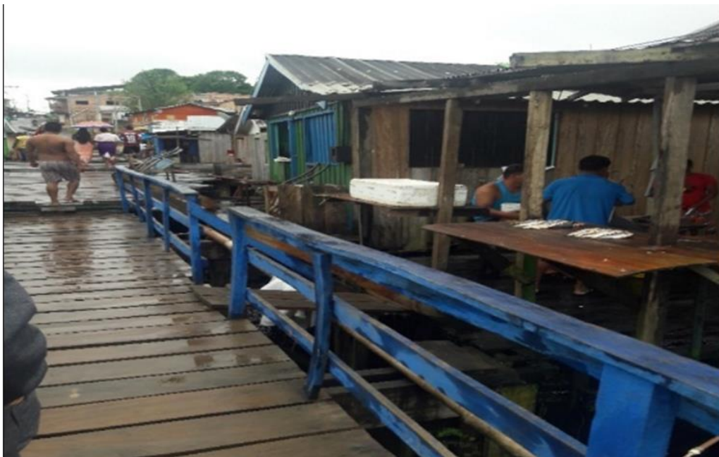
Figura 30: Ponte de Vila Pescoço – Principal Ponte do bairro. Fonte: Trabalho de Campo (foto: Naraiza C. Lira, 2020).
