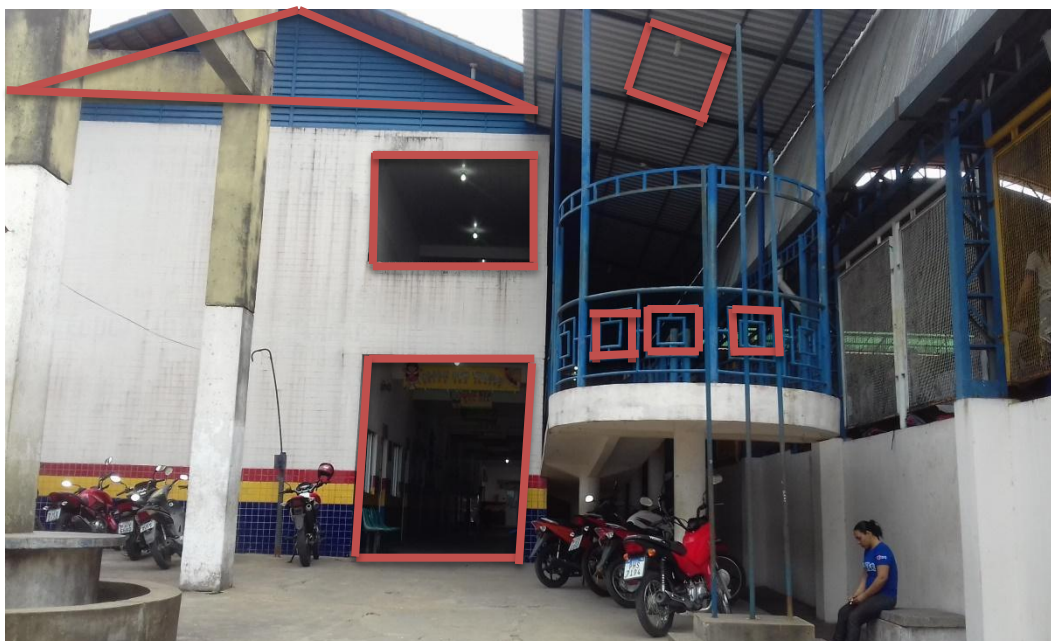
Foto 4: Entrada do 1 Centro de Aplicação Municipal em Educação Walter Cabral. Fonte: CURMAIARE (2020)
