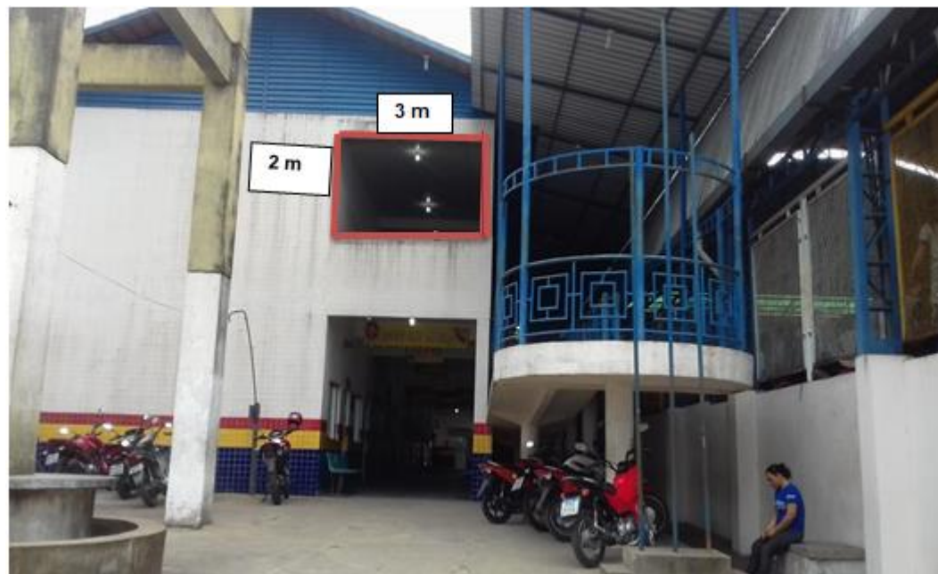
Foto 3: Entrada do 1 Centro de Aplicação Municipal em Educação Walter Cabral. Fonte: CURMAIARE, 2020
