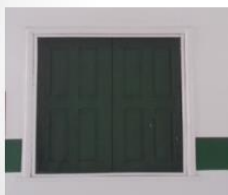
Foto 3: Janela de uma casa
