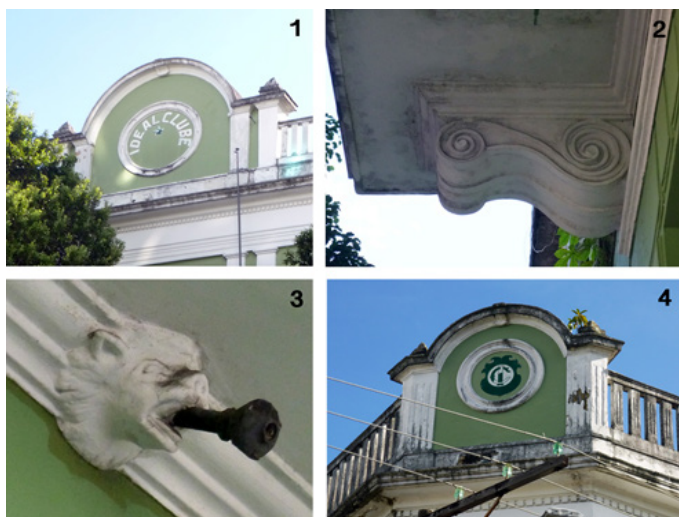
Figura 12. I. Frontão da fachada da Eduardo Ribeiro; II. Mísula com voluta abaixo dos balcões; III. Gárgula abaixo dos balcões; IV. Frontão da esquina com brasão do clube. Fotografias da autora.
