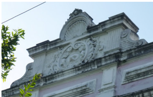
Figura 5. Frontão no topo da fachada, notar os guarnecimentos e a concha em baixo relevo. Fotografia da autora.
