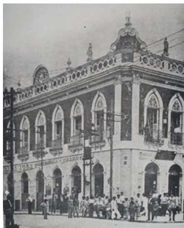
Figura 6. Aspecto da fachada da terceira sede do clube. (BRAGA, 1979, p. 96).
