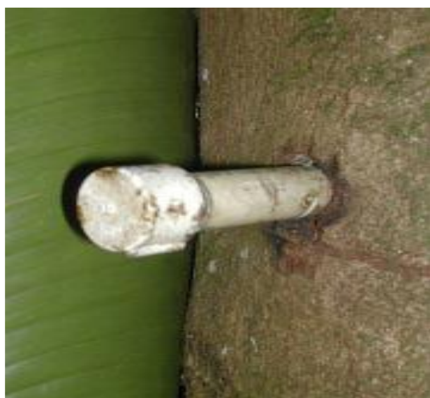
Figura 27: Cano vedado com uma tampa de PVC ao final da extração.
