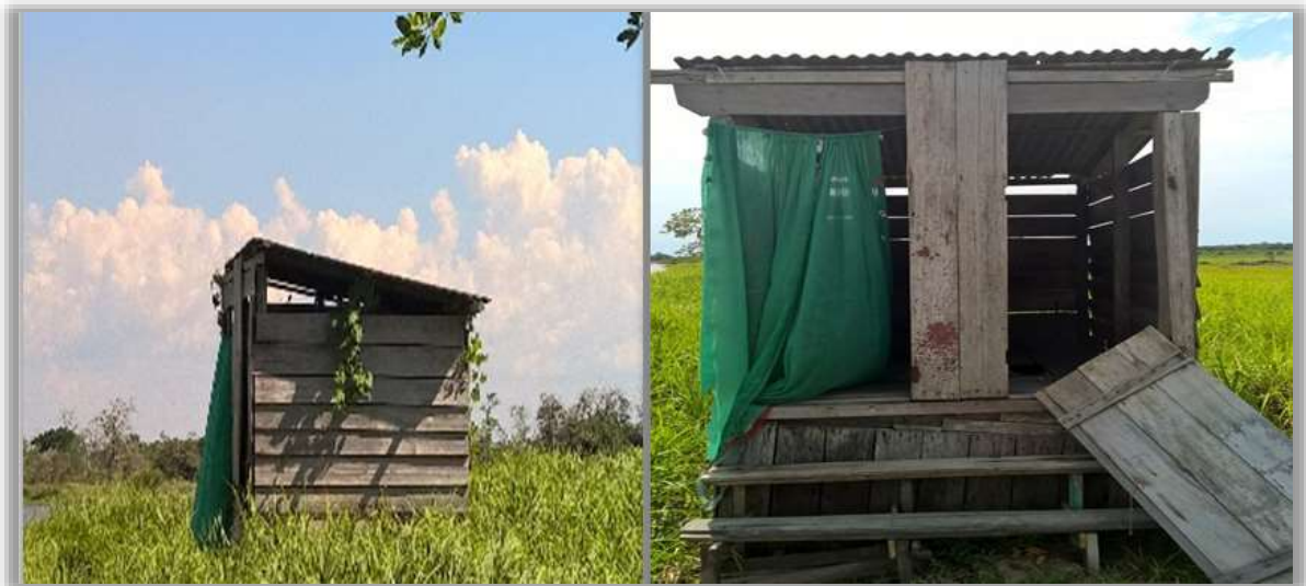
Figura 7: Sanitário da Escola Nossa Senhora de Nazaré
