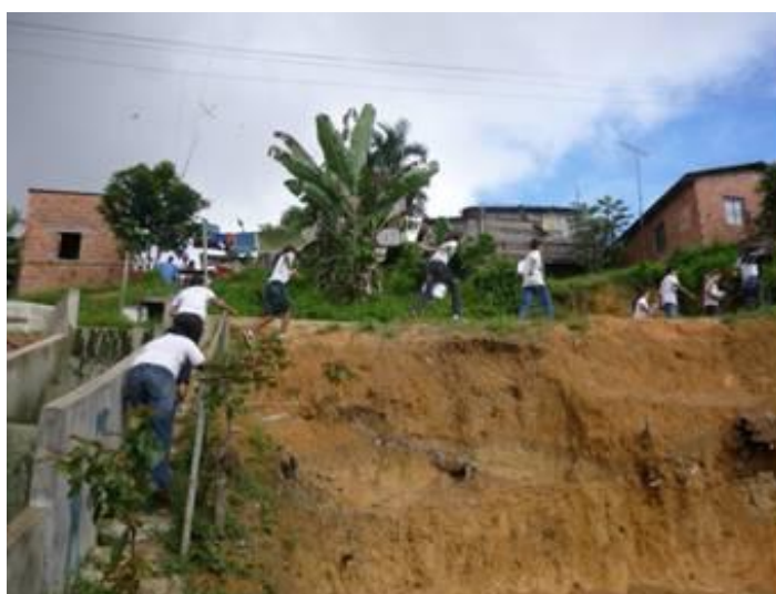
Figura 17: Parada na erosão da Lagoa. Fonte: Alzemir, 2009.
