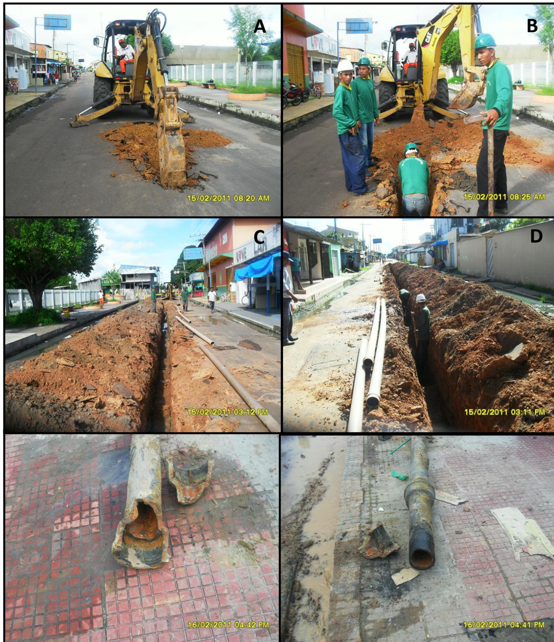
Figura 29: Substituição da tubulação do SAAE. A – Início das obras; B – Observação do estado da tubulação; C e D – Substituição da tubulação antiga de ferro por tubos de PVC de maior diâmetro; E e F - Tubos de ferro deteriorados.
