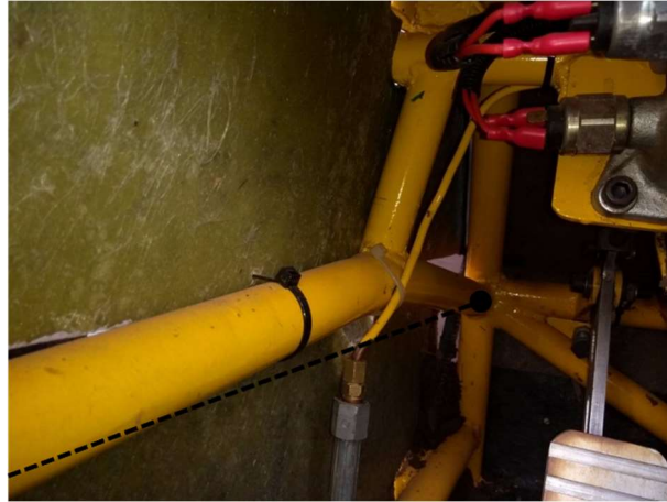
Figura 8 - Deformação na lateral esquerda vista por dentro do veículo
