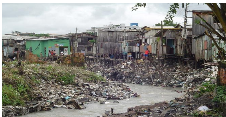
Figura 5 - IGA. do 40 próximo da Av. Manaus 2000 PIM às margens de uma comunidade que habita o igarapé em palafitas sem saneamento básico.
