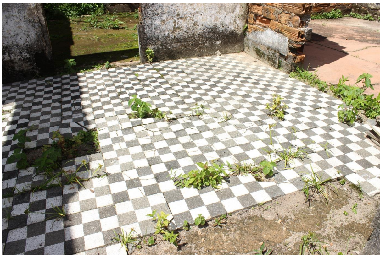
Figura 22 – Ladrilho da casa em ruínas no Fomento
