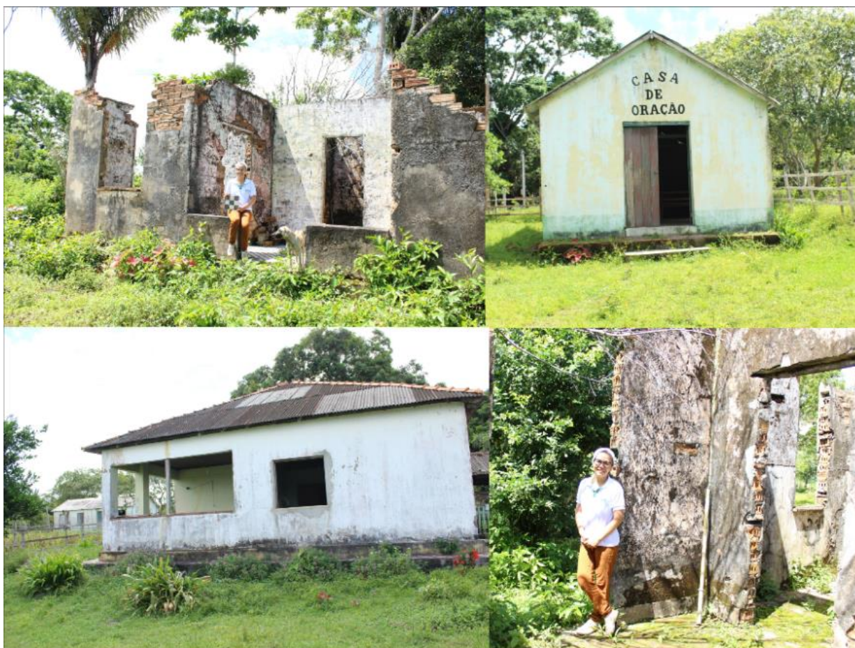
Figura 18 – Fomento: casa em ruínas
