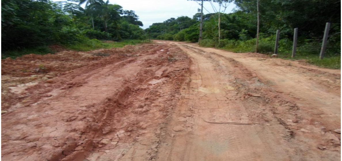
Figura 13 - Ramal construído, ainda sem pavimentação
