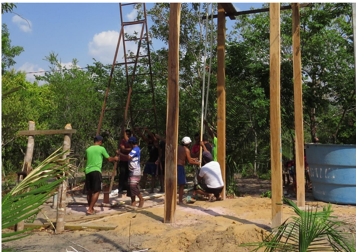
Figura 6 – Puxirum para construção do Microssistema de abastecimento de água da “Área Indígena”
