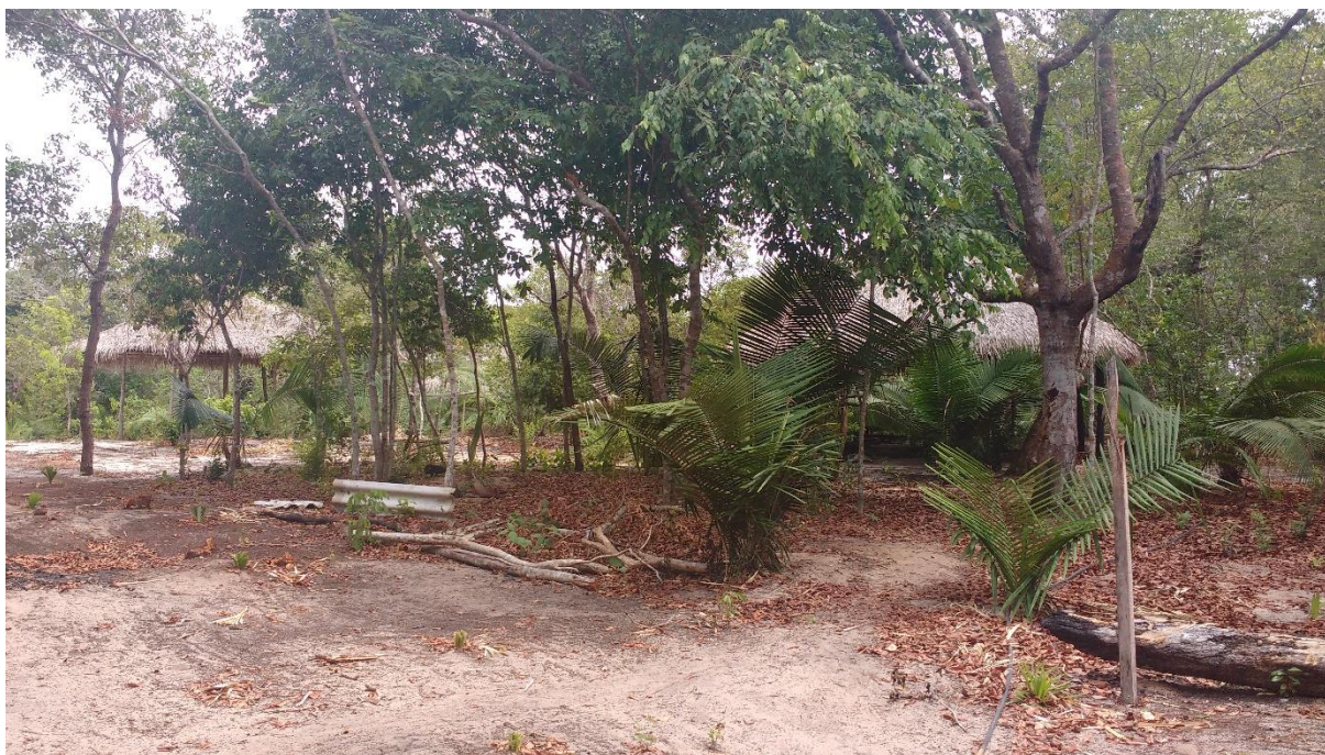
Figura 2: Malocas em construção na “Área Indígena”
